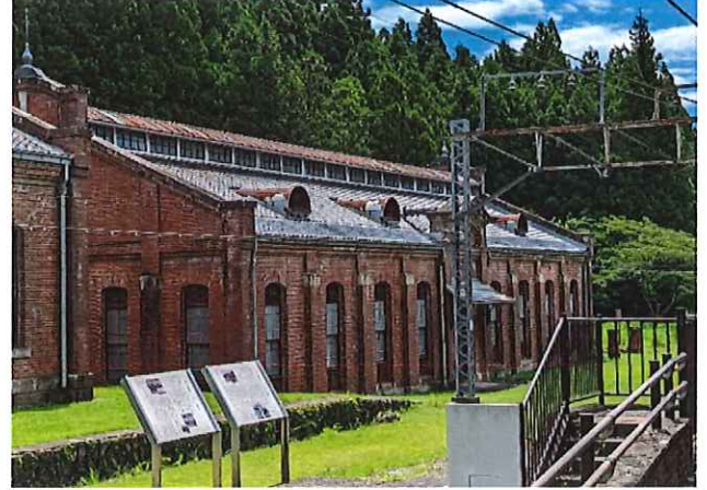
旧丸山変電所
